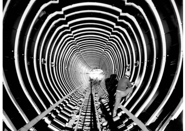
1972: inizio scavi SPS
