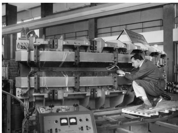
Montaggio della ciambella dell'Elettrosincrotrone nei Laboratori Nazionali di Frascati (Cortesia Archivio FotoVideo LNF)
